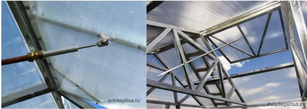
В первом случае усиление можно и не делать, только крепление надо устанавливать прямо через поликарбонат, при этом поликарбонат можно и сдавить. Во втором варианте надо укрепить место крепления проветривателя просто вложив в профиль отрезок такого же профиля и дополнительно прикрепить его саморезами.
